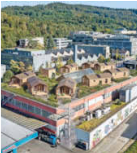
Links: Auch auf Dächern von Industriegebäuden sollen bald Wikkelhäuser stehen – wie hier in Dättwil.
